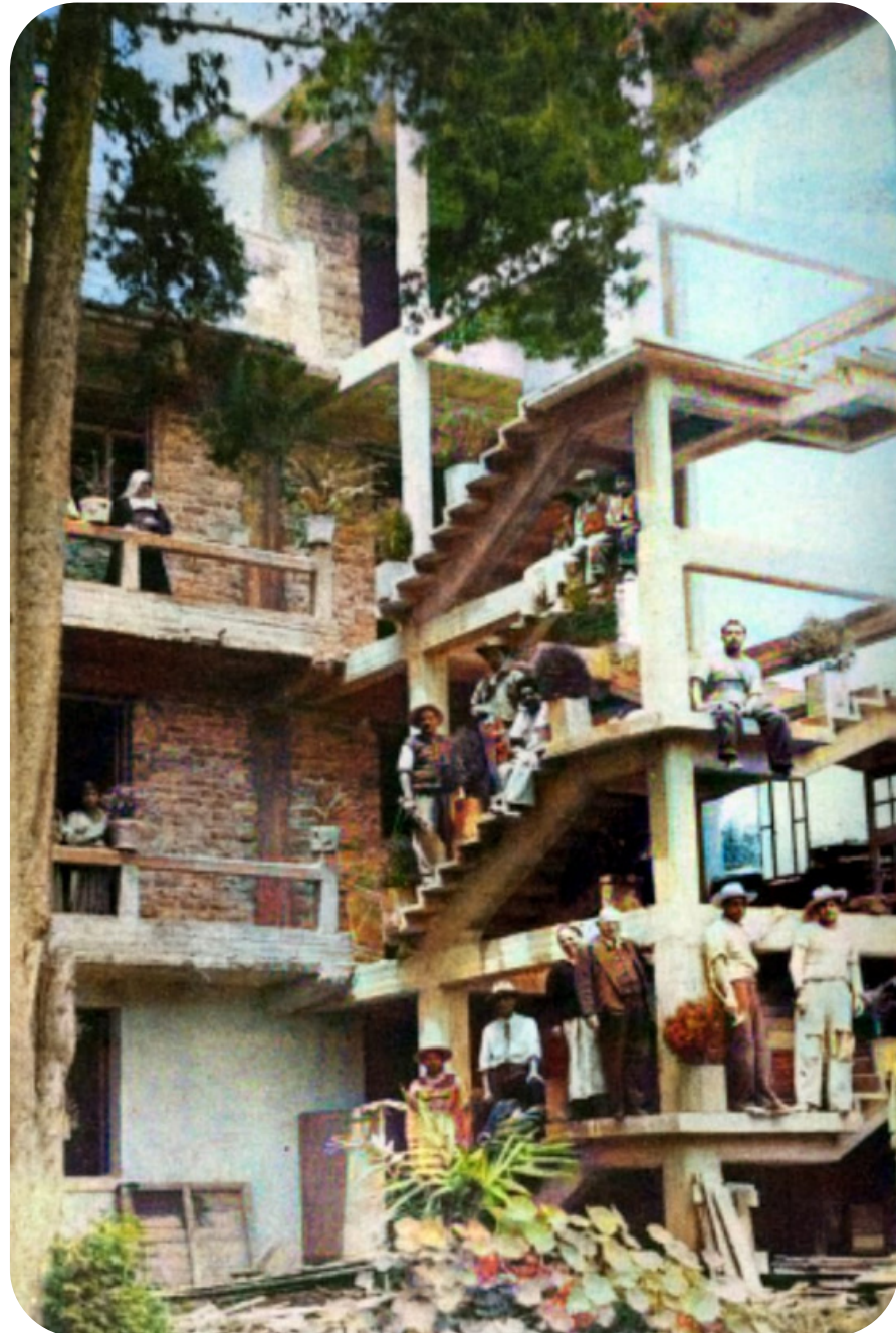
Foto: Hermano Juan Fromental en la construcción de la casa central
